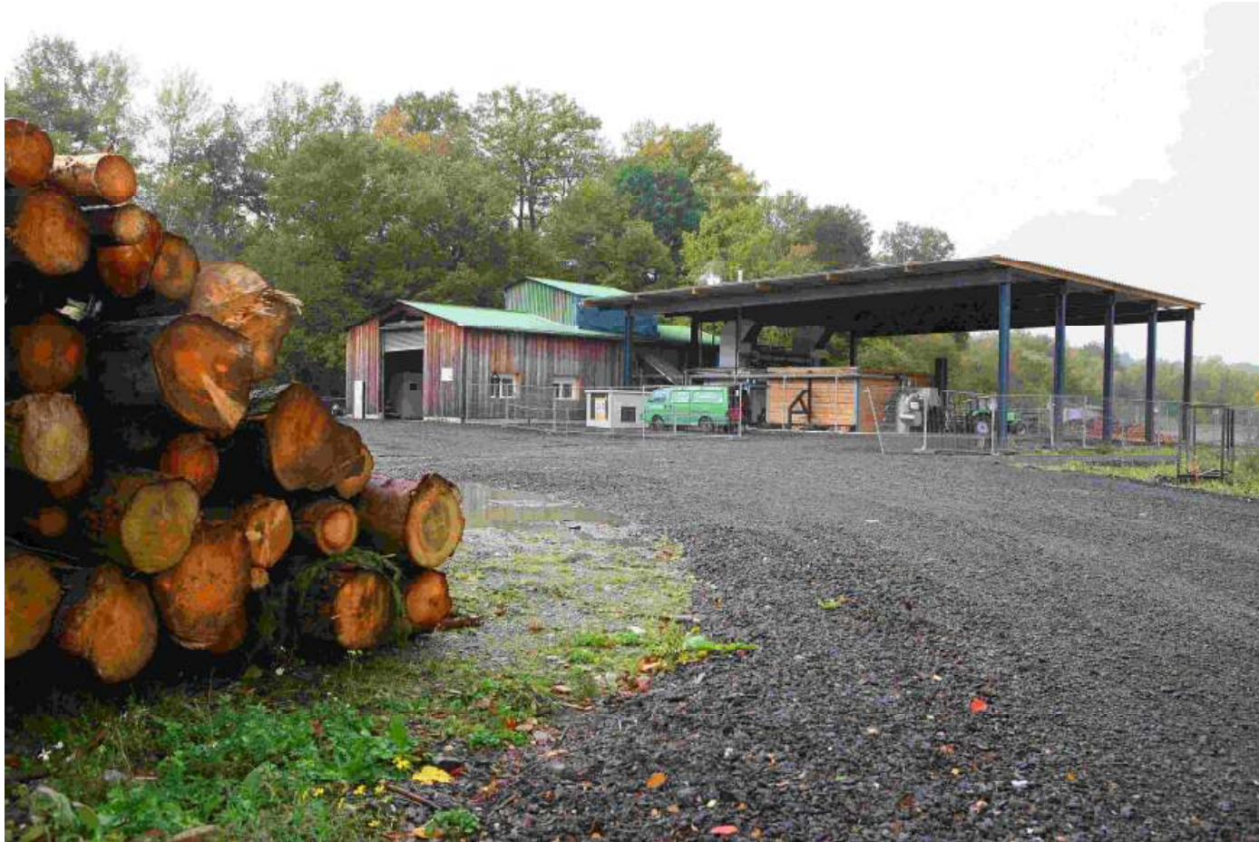
Frischholz-Vergasertechnologie mit Kraft-Wärme-Kopplung
