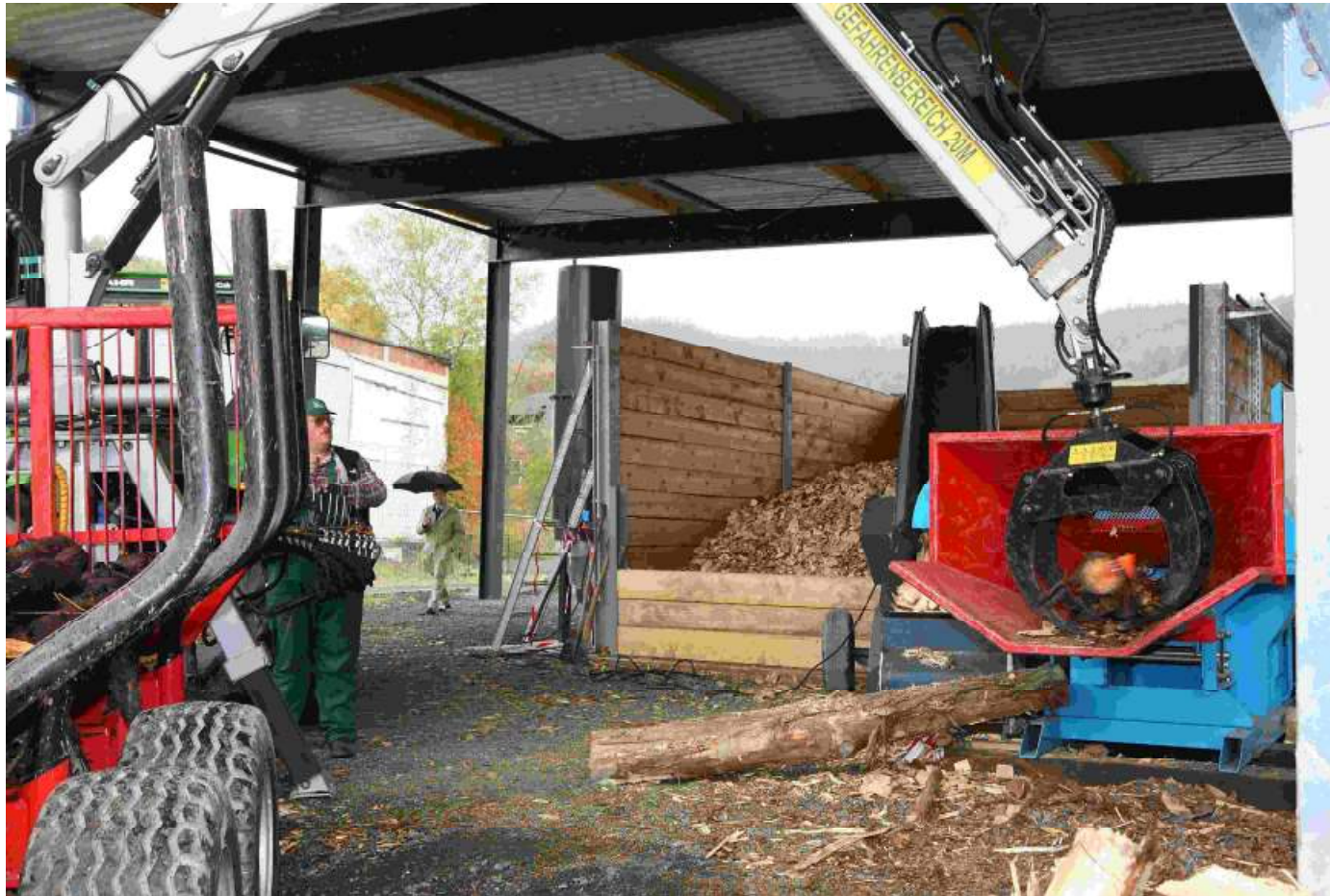
Frischholz-Vergasertechnologie mit Kraft-Wärme-Kopplung
