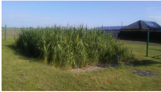
Abb. 13: Pflanzenkleinkläranlage am Nordbecker Weg, Werne Foto: Alexander Schmidt
