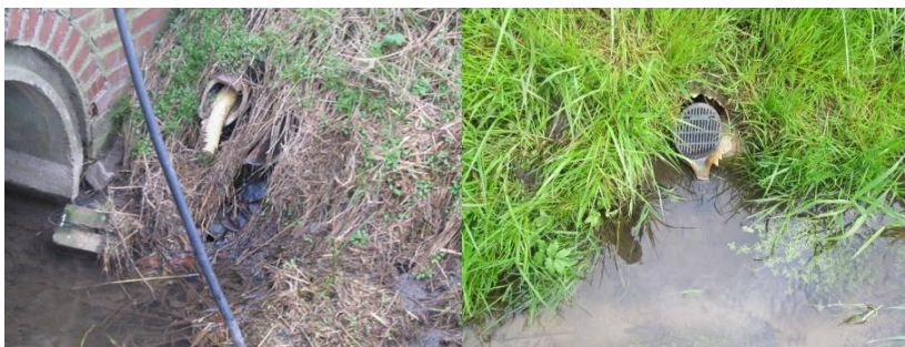
Abb. 12: Ablaufrohre (Hofablauf, Drainage, Kleinkläranlage) der Gewässer Im Hanloh und Nordbecker Weg, Werne Foto: Alexander Schmidt
