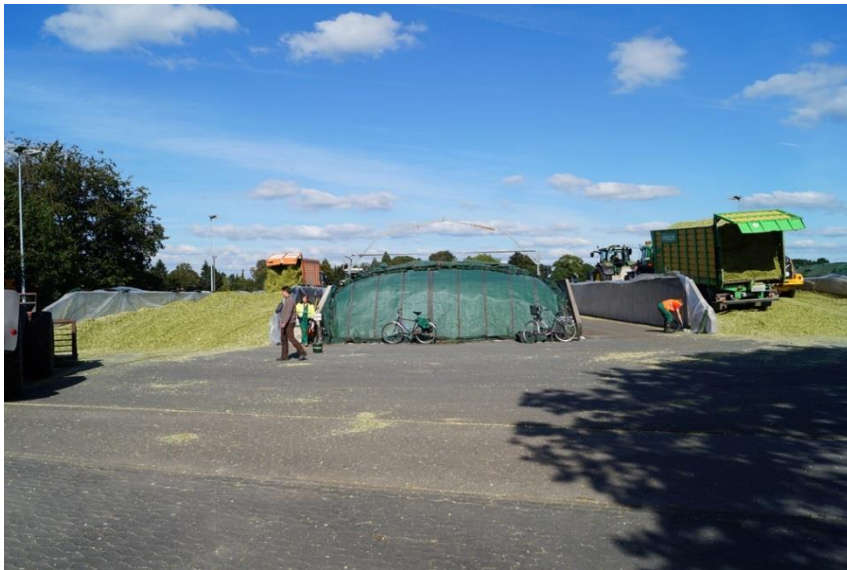
Abb. 3.1.2: Einlagerung des Frischmais in zwei baugleiche Fahrsilos
